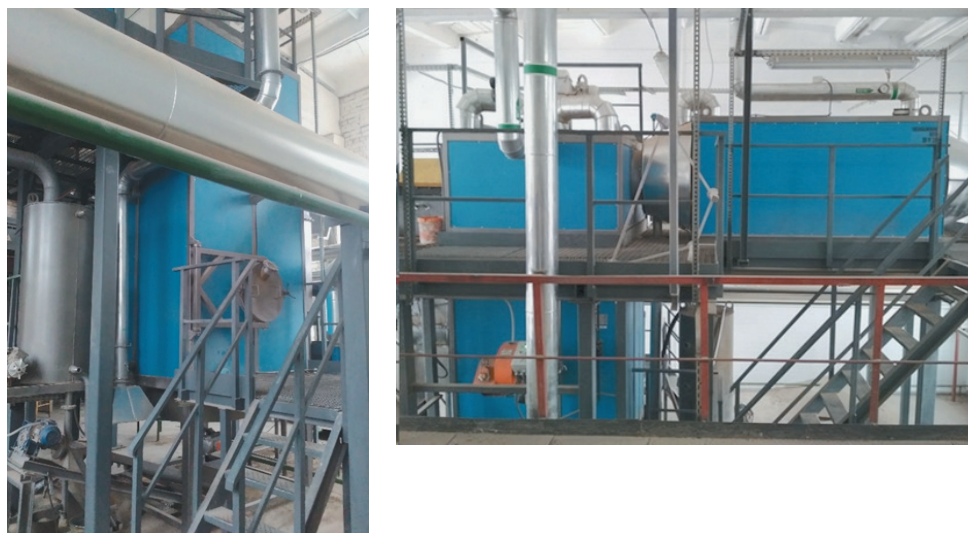
Рис. 2. Водогрейный котел мощностью 2 МВт с двухкамерной циклонно-слоевой топкой кипящего слоя (изготовитель – ОАО «ГСКБ», Брест)
